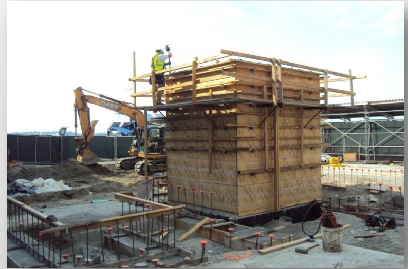
C10 Elevator Shaft Pour
